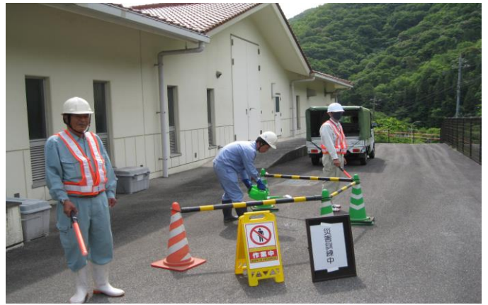
消毒作業(安全対策器具設置、交通整理員配置)
